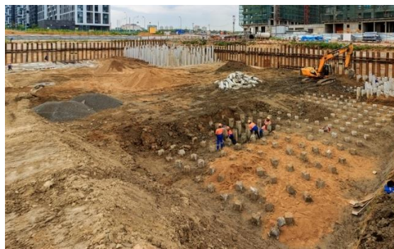
Рис.2- плитный фундамент на свайном основании.
