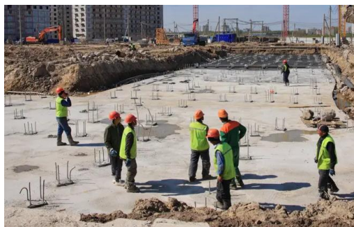
Рис.2- плитный фундамент на свайном основании.
