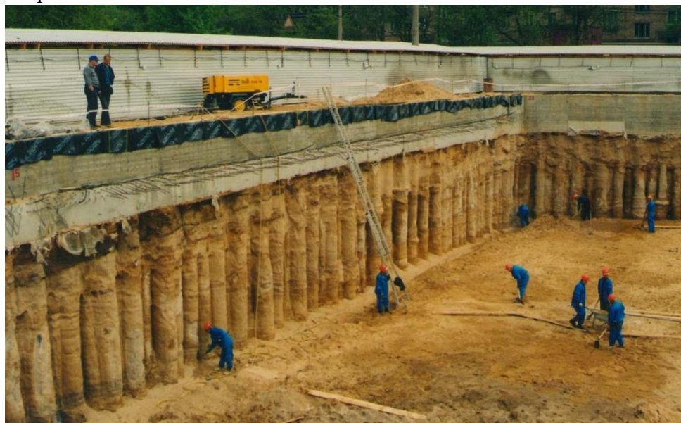
Рисунок 9. Пример устройства ограждения котлованов из буросекующихся свай.
